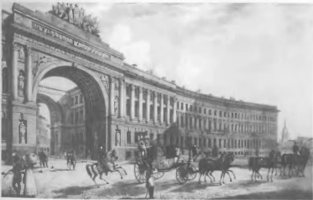
К. П. Бегтров. Здание Главного штаба. Вид с площади. 1822
