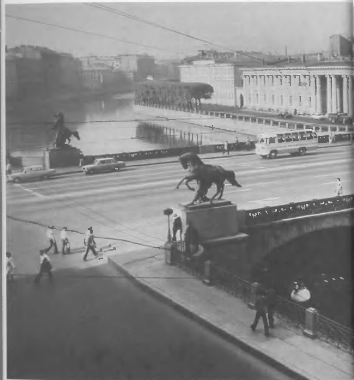
Аничков мост через Фонтанку
